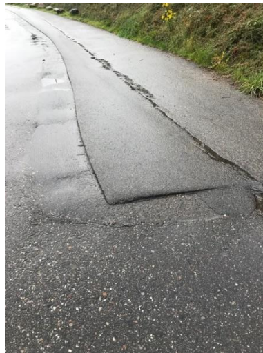
Høj kant/spring imellem ny og gammel asfalt.
